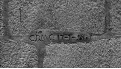
Un obrero quiso dejar un recuerdo de su implicación en las obras de Ouzande: CDMC, Cura Don Manuel Castiñeira, 17 de enero de 1971 (ábside templo de Ouzande).
