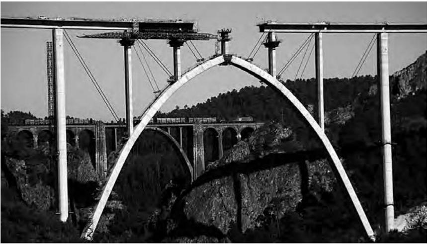
tes atirantan el arco desde el tablero. Se dispone además un tirante de retenida que compensa los esfuerzos inducidos sobre cada pila contigua atirantándola desde media altura hasta el encepado de la pila siguiente.
