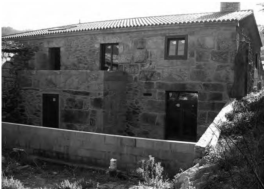
La casa de A Silva rehabilitada.
