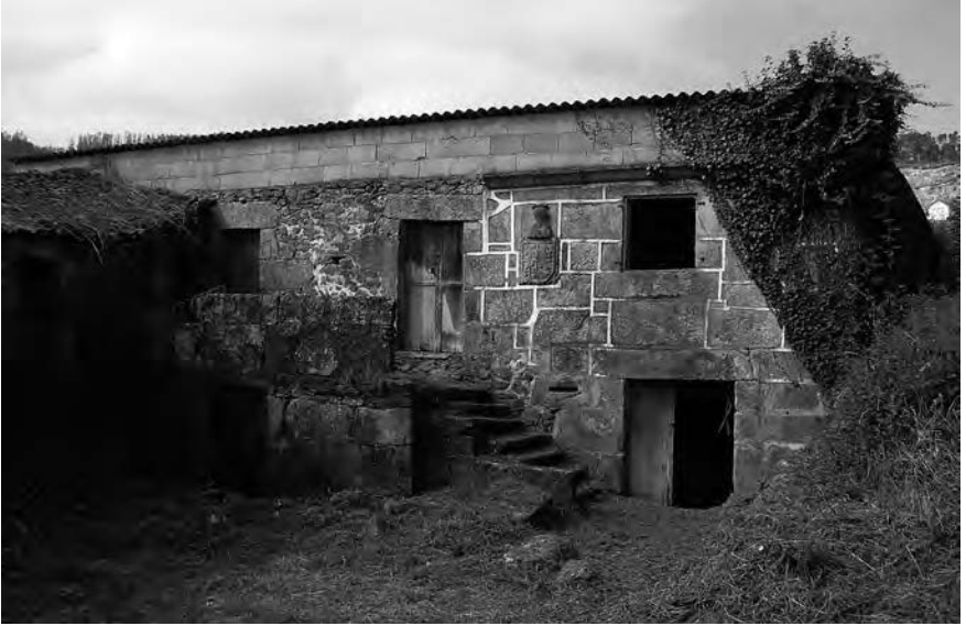
A casa da Silva antes de su restauración.
