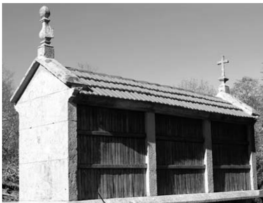
GUIMAREI. Lugar, Devesa. Situación, pináculo do hórreo na casa de Alonso. Forma, rectangular, rematado en semicírculo en forma de coroa; carece de gnomon Tipo, vertical ortomeridiano. Estado de conservación, moi desgastado, no se aprecia restos de numeración. Propietario Luís Tato.
