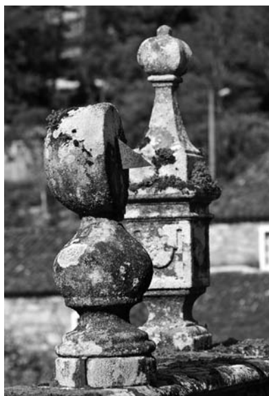
OCA. Lugar, Pazo de Oca. Situación, na balastrada que desde o interior do pazo conduce á capela, no único pináculo redondo, Forma circular; gnomon de chapa triangular. Tipo vertical ortomeridiano. Estado de conservación bo. Propiedade Fundación Casa Ducal de Medinaceli.
