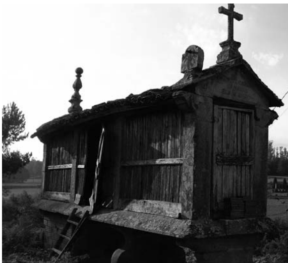
RUBÍN. Lugar, Amarelle. Situación: sobre un hórreo vese un ben labrado reloxo de sol que descansa sobre unha ménsula ubicada nun dos extremos do remate do tellado. Forma rectangular. Nunha inscrición do lateral indícase que foi construído por Carlos Canabal no ano 1830. Ten a posibilidade de poder ser orientado. Remata nun semicírculo; gnomon de chapa en forma triangular. Tipo, vertical ortomeridiano. Estado de conservación bo.
