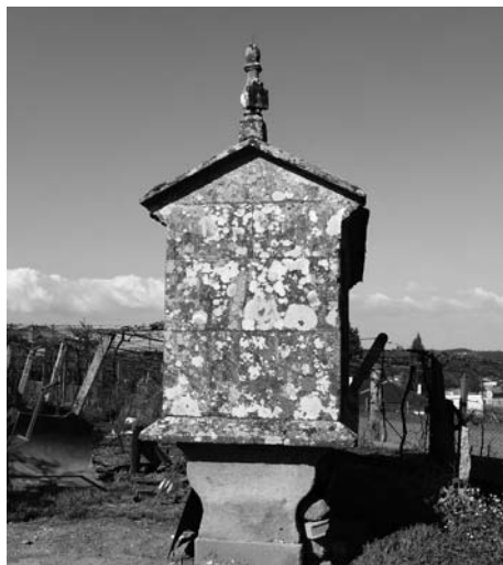
LAGARTÓNS. Lugar, Viso. Situación, nun hórreo; está labrado sobre o pináculo. Forma rectangular, rematado en semicírculo en forma de coroa; carece de gnomon. Tipo, vertical ortomeridiano. Estado conservación malo; atópase cargado de brión e liques. Propiedade, Amelia Barreiro Barcala.
