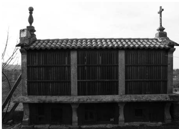
PARDEMARÍN. Lugar, Parada número 16. Situación, tellado do hórreo. Forma, rectangular; pedra con rebaixe; encaixa unha peza de mármore onde se atopan marcadas as liñas horarias e o gnomon. Dátase no ano 1868 cando se fixo o hórreo. Tipo, vertical ortomeridiano, orientado ó Sur. Estado de conservación excelente. Propiedade de María Lina Loureiro.
