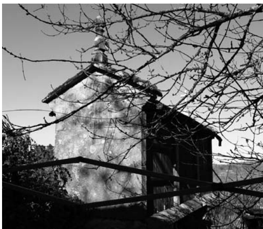
GUIMAREI. Lugar, Devesa. Situación, pináculo do hórreo na casa de Xan. Forma, rectangular, rematado en semicírculo en forma de coroa é mantén o gnomon. Tipo, vertical ortomeridiano. Estado de conservación, regular; moitos líques e musgo.
