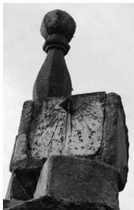
PARDEMARÍN. Lugar, Parada número 16. Situación, tellado do hórreo. Forma, rectangular; pedra con rebaixe; encaixa unha peza de mármore onde se atopan marcadas as liñas horarias e o gnomon. Dátase no ano 1868 cando se fixo o hórreo. Tipo, vertical ortomeridiano, orientado ó Sur. Estado de conservación excelente. Propiedade de María Lina Loureiro.
