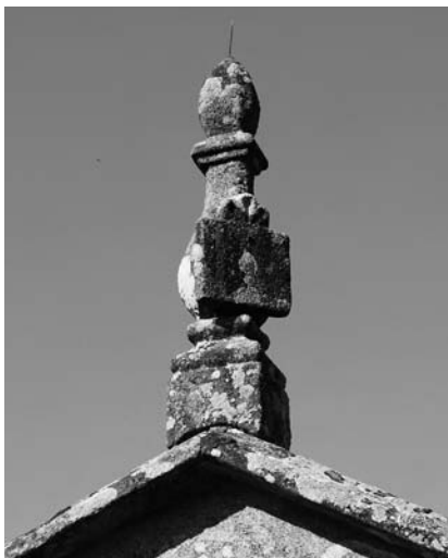
LAGARTÓNS. Lugar, Viso. Situación, nun hórreo; está labrado sobre o pináculo. Forma rectangular, rematado en semicírculo en forma de coroa; carece de gnomon. Tipo, vertical ortomeridiano. Estado conservación malo; atópase cargado de brión e liques. Propiedade, Amelia Barreiro Barcala.
