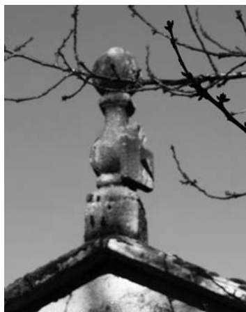
GUIMAREI. Lugar, Devesa. Situación, pináculo do hórreo na casa de Xan. Forma, rectangular, rematado en semicírculo en forma de coroa é mantén o gnomon. Tipo, vertical ortomeridiano. Estado de conservación, regular; moitos líques e musgo.
