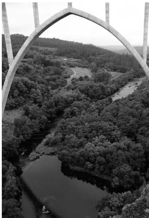
O Pozo de San Xoán da Cova está nesta zona máis ancha do río Ulla entre os viadutos do ferrocarril do Gundián, novo e vello. Foto: Henrique Neira, 2013
